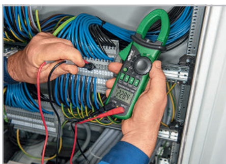
在开关柜中进行电压测量
